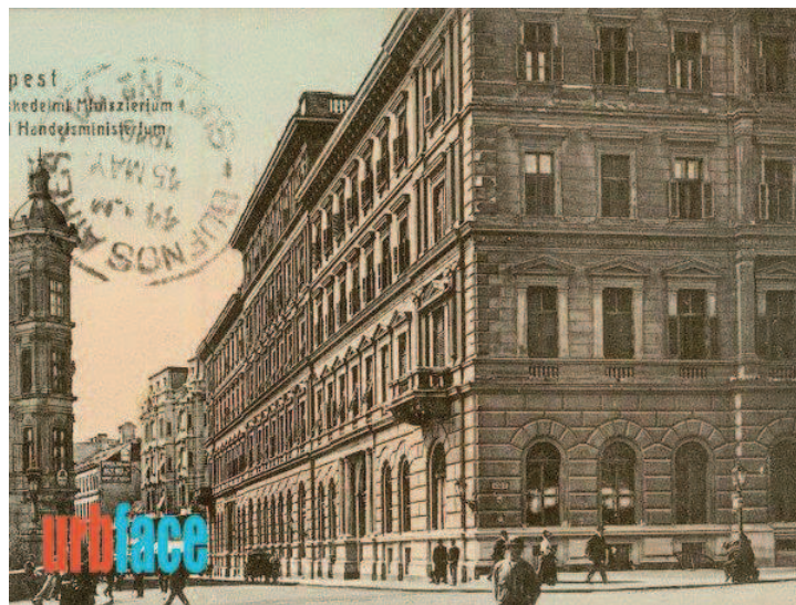
6. ábra A Magyar Nyugoti Vasút saját Igazgatósági épülete
