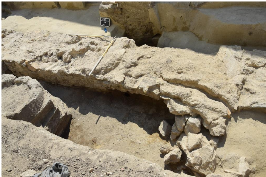
Abb. 16. Ein Strebepfeiler bei der nordwestlichen Mauerecke. Photo: Szabina Reich
