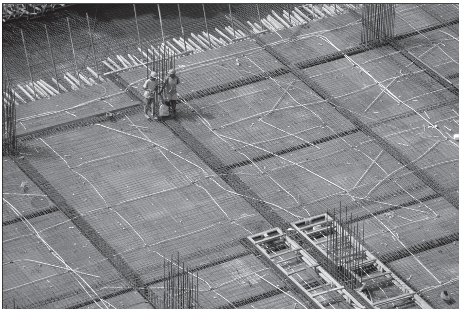
Újabb magas épületet húznak fel – igen, helybéli munkások! Fotó: Kalmár Lajos, 2011
