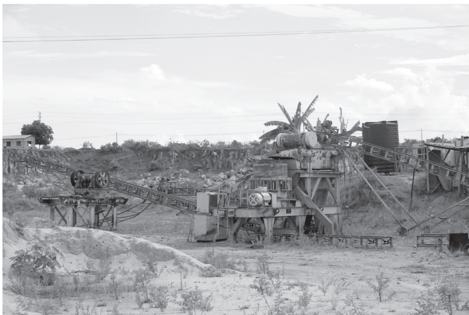
▲ Solomon Kimaro építkezési-kivitelező cégének egyik kőbányája, Dar es-Salaam, 2006. Fotó: Kalmár Lajos
