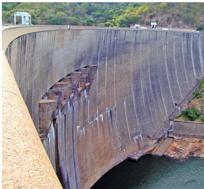
▲ Kariba-vízerőműrendszer (Zambia) fotó: ChanMuk
