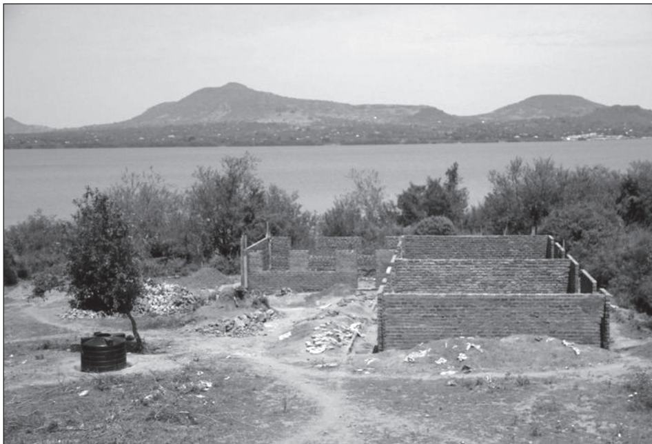
Az épülő iskola
