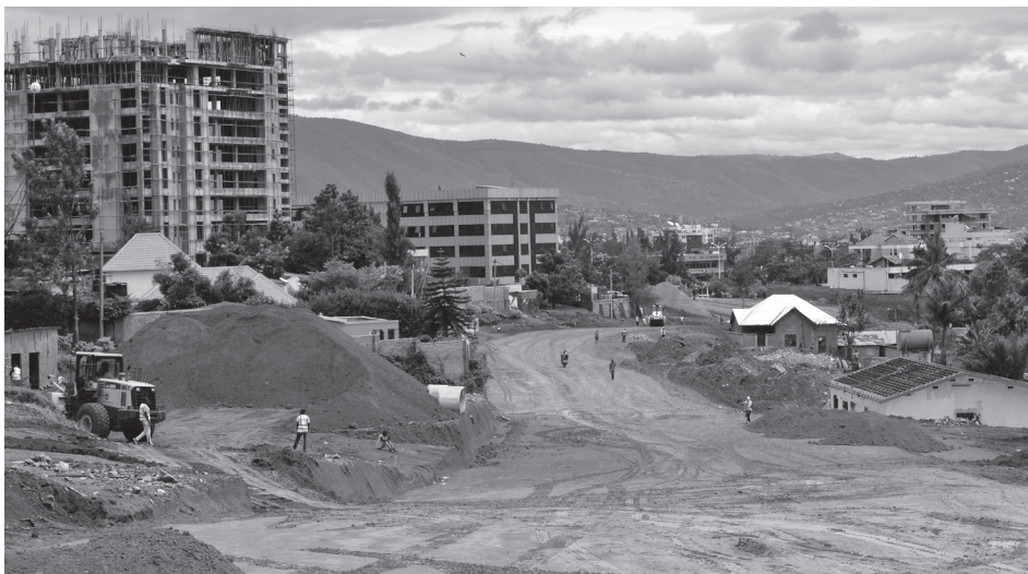
▲ Fontos elkerülőút építése Kigaliban (Tarrósy István, 2016)
